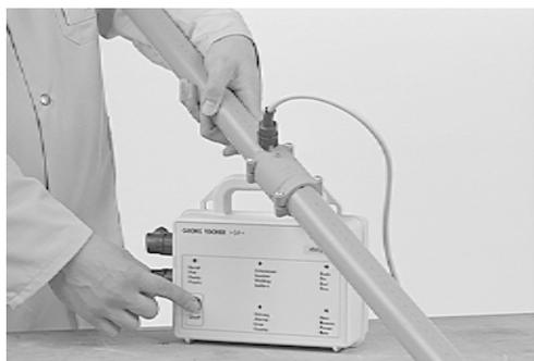
Para realizar una unión por electrofusión basta con conectar el cable de soldadura procedente de la unidad de control en el accesorio.
